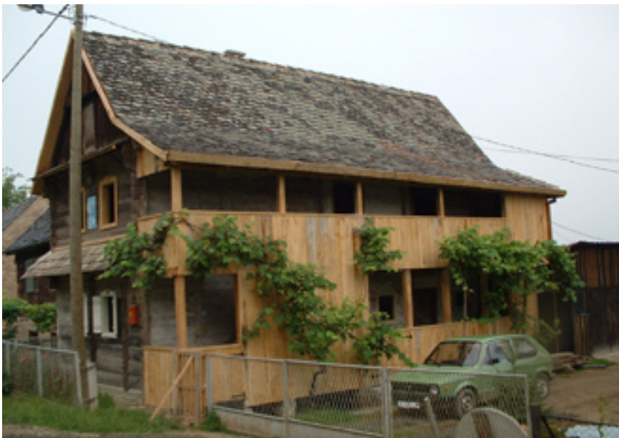
Obnova kuće u Krapju br. 164
