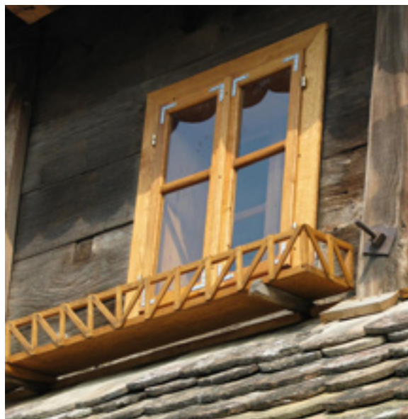
Obnovljeni prozor s ograđenom klupicom za cvijeće
