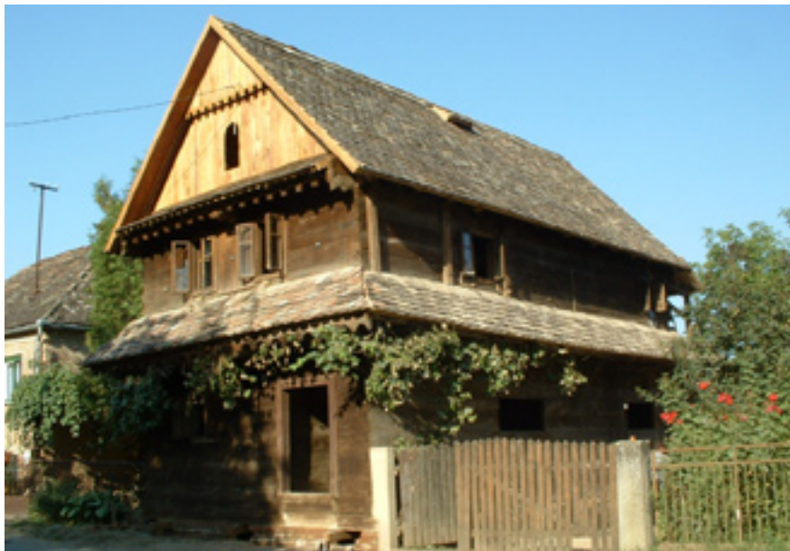
Obnova kuće u Krapju br. 30
