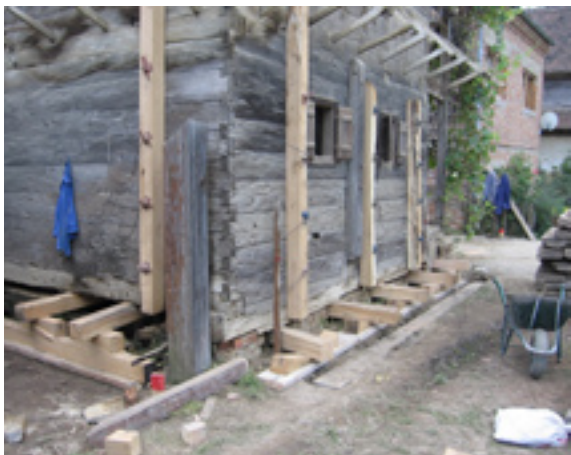
Sanacija temelja s niveliranjem kuće
