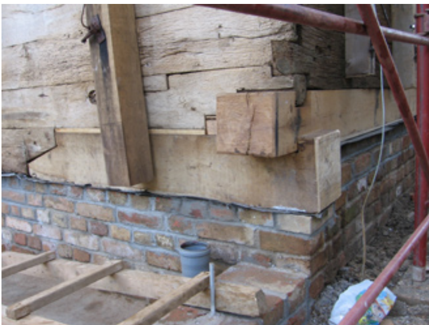
Zamjena trulih greda u podseku s podzidavanjem i hidroizolacijom nadtemelja
