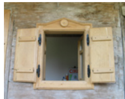
Obnovljeni prozor s kopcima
