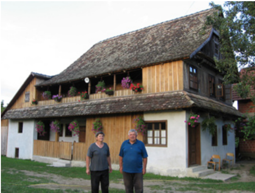
Obnova kuće u Lonji br. 1
