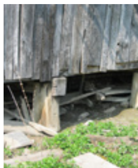
U starije vrijeme kao temelji u poplavnim krajevima služili su i hrastovi stupci („bapke“ – prežitak iz vremena sojenica)
