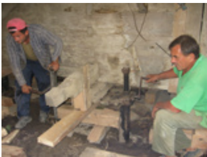
Podizanje stijenke kuće vintama (autodizalicom) pri niveliranju
