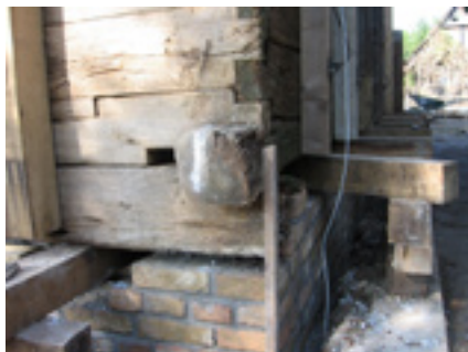
Podzidavanje nadtemelja ispod poduprtih podseka
