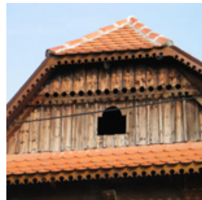
Zadržani i obnovljeni uresi na krovnim letvama zabatnog trapeza i podrožnice zabatnog krova
