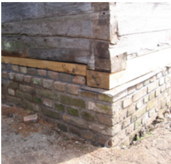
Obnovljeni nadtemelj od opeke sa saniranim i hidroizoliranim podsekom
