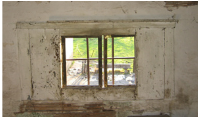
Tradicijski klizni prozor (krila se uvlače u šupljinu između stijenke od planjke i daščanog opšava)
