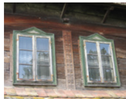
Postojeći prozori na glavnom (uličnom) pročelju kuće
