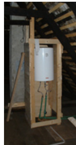
Zbog malog raspoloživog prostora u kupaonici bojler za toplu vodu može se smjestiti u toplinski izoliranu kabinu na tavanu
