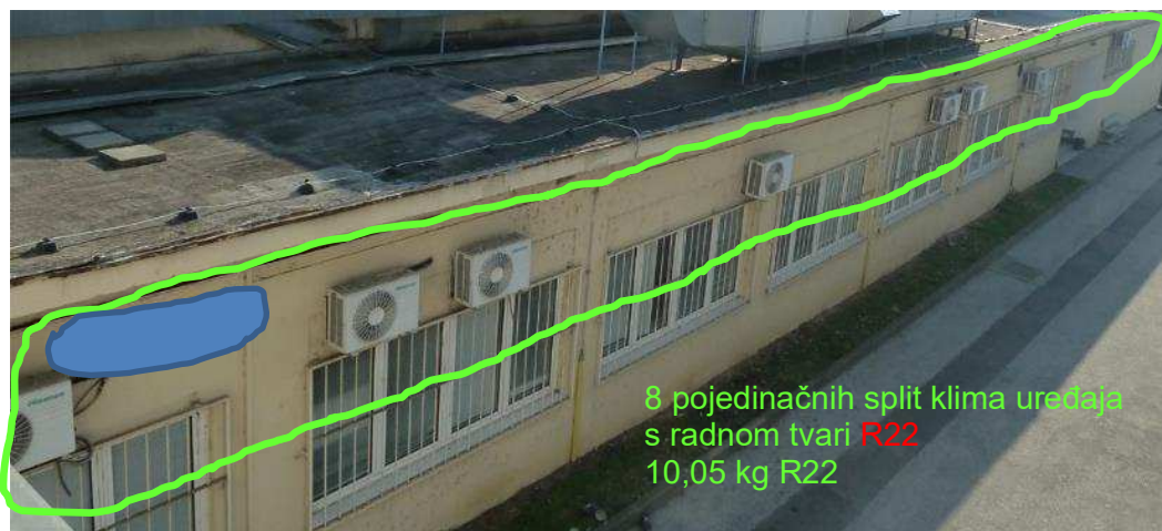
Slika 3-19 Decentralni sustav hlađenja pomoću pojedinačnih split klima uređaja s radnom tvari R22
