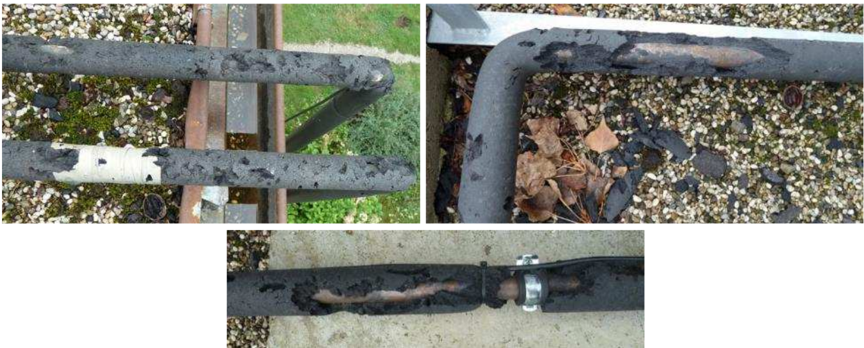
Slika 8-19 Neprikladna toplinska izolacija vanjskog dijela cijevnog razvoda do solarnih kolektora
