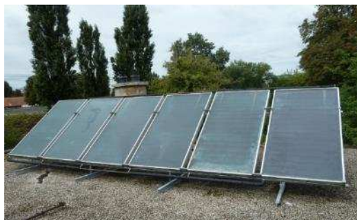
Slika 5-26 Solarni kolektori za pripremu potrošne tople vode za potrebe sportskog kluba
