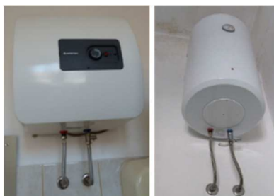
Slika 3-13 Električni akumulacijski zagrijači vode
