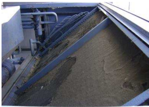
Slika 3-21 Onečišćena orebrena površina zrakom hlađenog kondenzatora kompresijskog rashladnog uređaja
