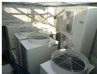
Slika 8-39 Vanjske jedinice VRV sustava proizvođača HITACHI s radnom tvari R410A za potrebe hlađenja/grijanja hotela
