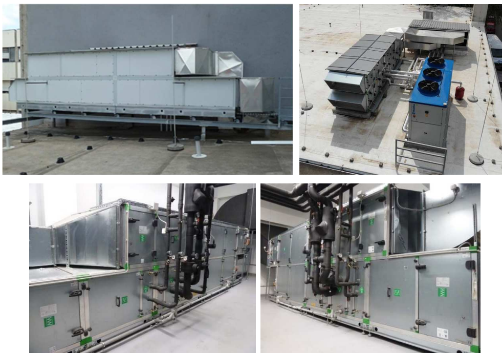
Slika 8-38 PRIMJER 3 – termotehnički sustav bolničkog kompleksa – sustav mehaničke ventilacije/klimatizacije kroz slike
