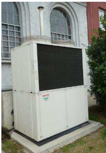
Slika 3-23 Kompresijski rashladni uređaji pogonjen plinskim motorom proizvođača SANYO model SGP-E190 rashladne snage 56 kW s R407C
