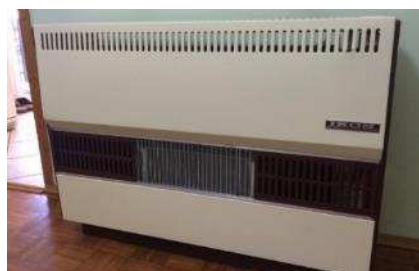
Slika 3-5 Pojedinačna plinska peć proizvođača IKOM
