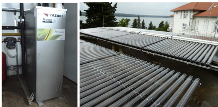
Slika 8-42 Apsorpcijski rashladnik vode proizvođača YAZAKI ukupne rashladne snage 17,6 kW pogonjen Sunčevom energijom (površina apsorbera 36,288 m 2 ) s radnom tvari LiBr-H 2 O (litij bromid - voda)
