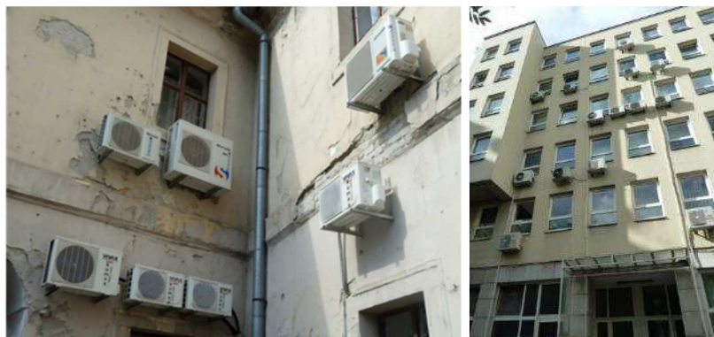
Slika 3-18 Decentralni sustav hlađenja pomoću pojedinačnih split klima uređaja
