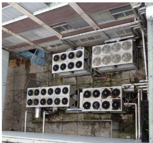
Slika 3-22 Nepovoljni smještaj četiri kompresijska rashladnika zrakom hlađena – smješteni u tzv. „rupi“ – loša cirkulacija zraka
