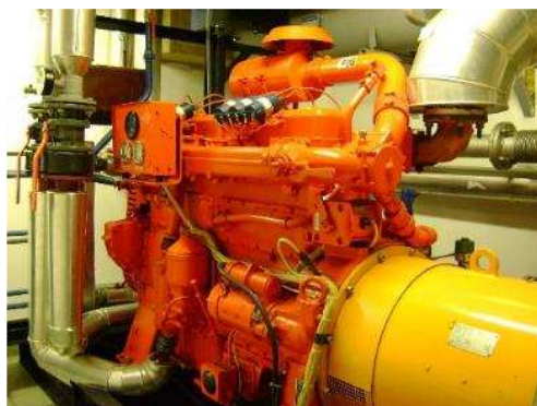
Slika 8-20 Kogeneracijsko postrojenje električne snage 75 kW i toplinske snage 150 kW na prirodni plin iz 2000. godine
