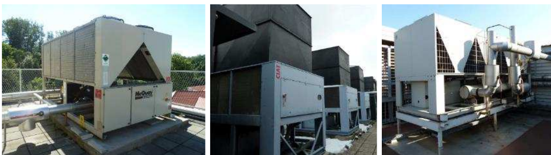
Slika 3-20 Kompresijski rashladni uređaji pogonjeni električnim motorom
