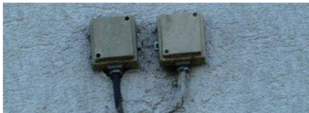
Slika 8-21 Dva vanjska osjetnika temperature za regulaciju rada sustava grijanja na sjevernom zidu škole (dva standardna kotla)
