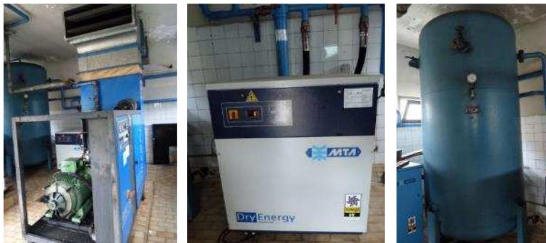
Slika 3-40 Osnovni elementi kompresorskog sustava – kompresor, sušač zraka, spremnik komprimiranog zraka
