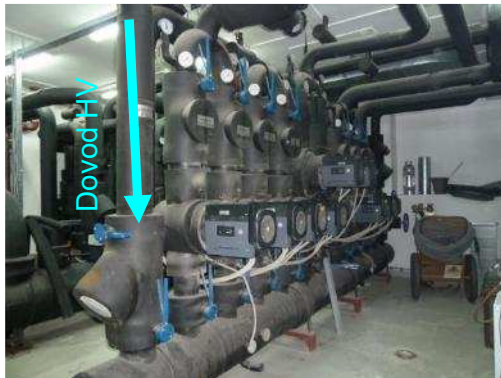
Slika 3-26 Razdjelnik s polaznim krugovima hlađenja i pripadajućim cirkulacijskim crpkama
