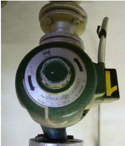
Slika 8-23 Crpka s konstantnim brojem okretajem (neregulirana)
