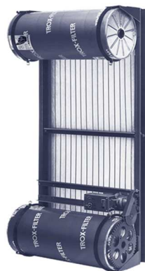
Slika 8-29 Filterska traka i pomični rol filter
