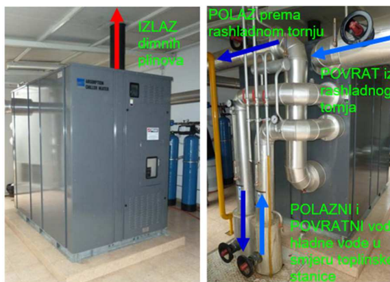
Slika 8-41 Plinski apsorpcijski rashladnik vode japanskog proizvođača EBARA RAP G-006 ukupne rashladne snage 211 kW s radnom tvari LiBr-H 2 O (litij bromid - voda) – faktor hlađenja \zeta \cong 1,00
