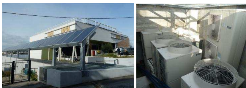
Slika 5-29 Solarni kolektori i vanjske jedinice VRV sustava
