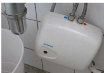
Slika 3-14 Električni protočni zagrijač vode KONČAR tip ETA 0733 električne snage 3,5 kW
