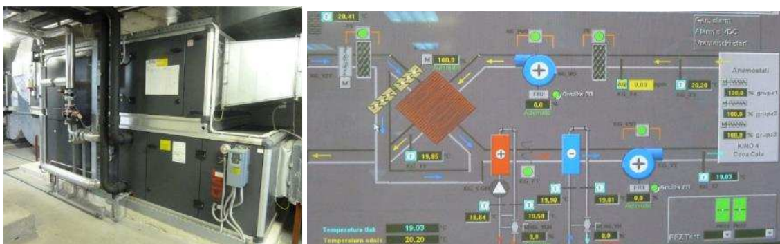
Slika 3-34 Pogled na klima komoru s frekventno upravljanim ventilatorima i unakrsnim pločastim rekuperatorom i pripadajućom shemom
