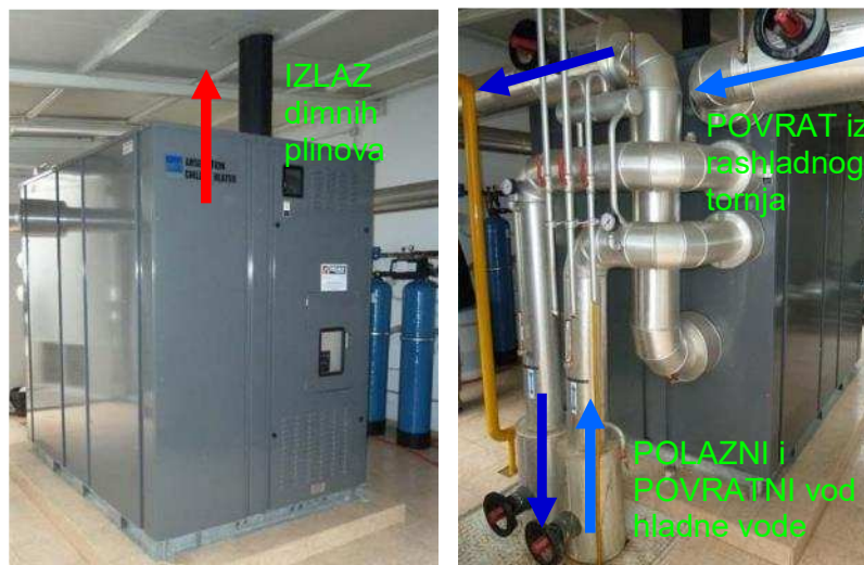
Slika 3-24 Plinski apsorpcijski rashladnik vode japanskog proizvođača EBARA RAP G-006 rashladnog učina 211 kW s otopinom litijbromid-voda kao radnom tvari
