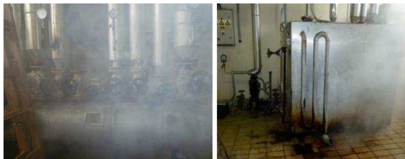
Slika 3-39 Razdjelnik pare s pripadajućim spremnikom kondenzata – neprimjereno stanje
