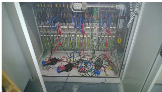
Slika 3-41 Mjerenja električnih veličina strujnim kliještima
