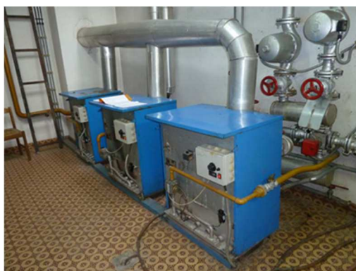
Slika 8-11 Tri standardna atmosferska plinska kotla proizvođača BUDERUS iz 1977. godine
