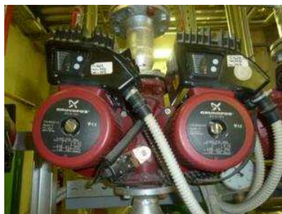
Slika 8-22 Dvojna izvedba cirkulacijske crpke na jednom polaznom krugu grijanja
