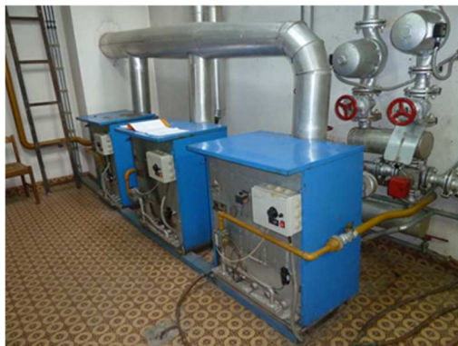
Slika 8-10 Tri standardna atmosferska plinska kotla proizvođača BUDERUS ukupne nazivne toplinske snage 3 \times 63 = 189 \text{ kW}
