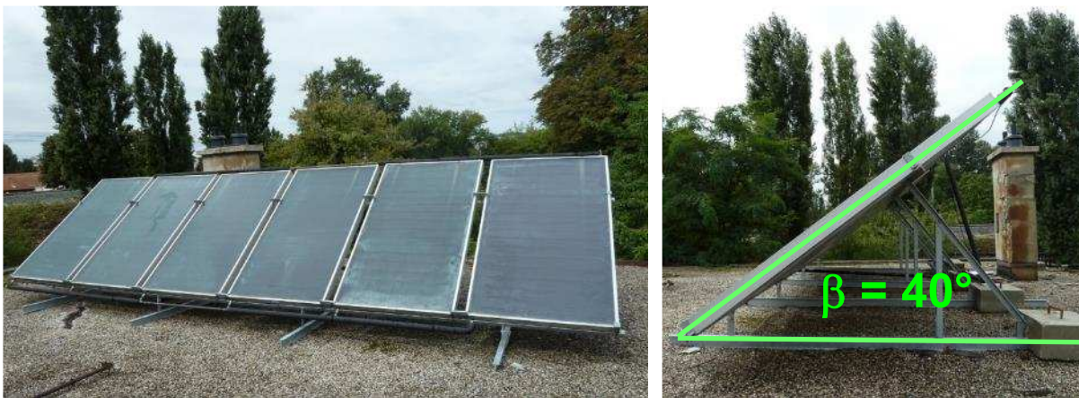
Slika 8-16 Pločasti solarni kolektori proizvođača TEHNOMONT tip SKT 40 na ravnom krovu zgrade
