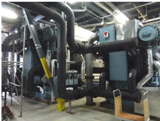
Slika 8-40 Dva dvostupanjska apsorpcijska rashladnika pogonjena parom proizvođača THERMAX LIMITED ukupne rashladne snage 6.894,25 kW s radnom tvari LiBr-H 2 O (litij bromid - voda) – faktor hlađenja \zeta = 1,30
