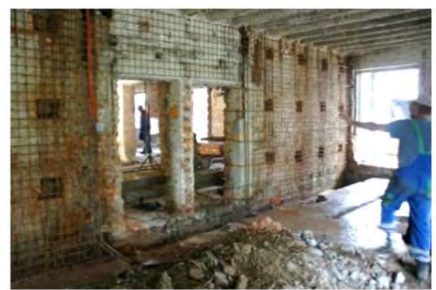
Slika 5.66 Ojačanje torkretnom oblogom izvana i izvedba horizontalne dijafragme
