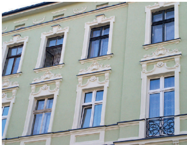
Sl. 13. Rekonstrukcija povijesne fasade polistirenskim profilima.
