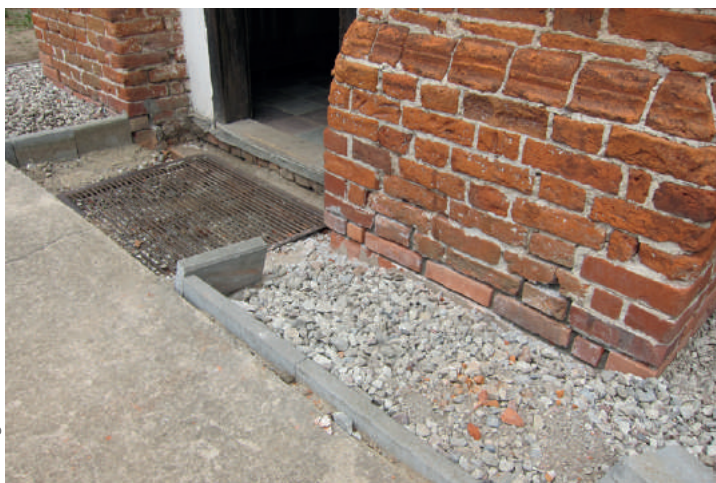
Sl. 9. Neispravna nivelacija terena i odvodnja: pločnik iznad „linije 0“ zgrade; novi rubnjak koji će zadržavati vodu uz zid te šljunak od kojeg će se kiša odbijati i vlažiti zid. Foto: Bogumiła J. Rouba, 2012.
