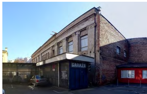
slika 11. sjeverno pročelje Zgrade skladišta
